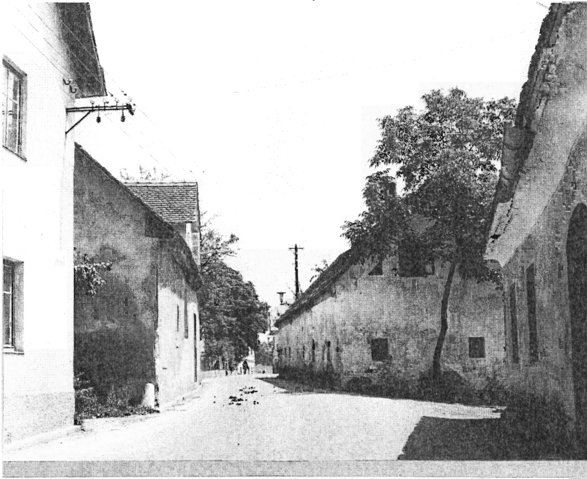
Stara Loka - št. 11, 9 in 8 - slednja bo v kratkem porušena
